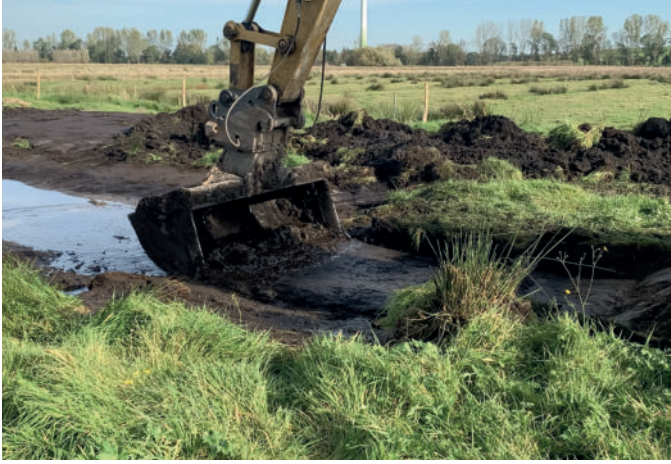
Bei der Renaturierung werden mit einem Bagger die Oberflächen abgehoben.
